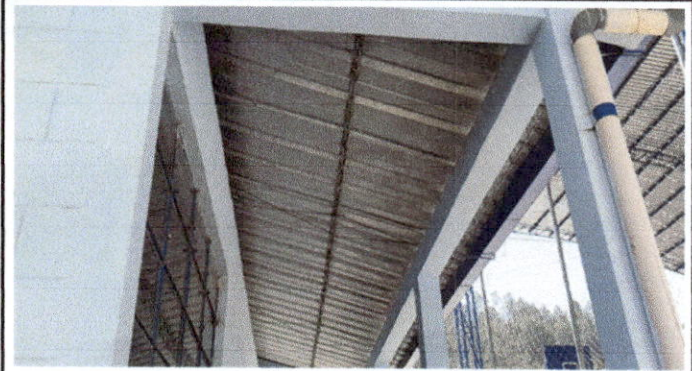
Foto 2: CAMBIO DE ESTRUCTURA
