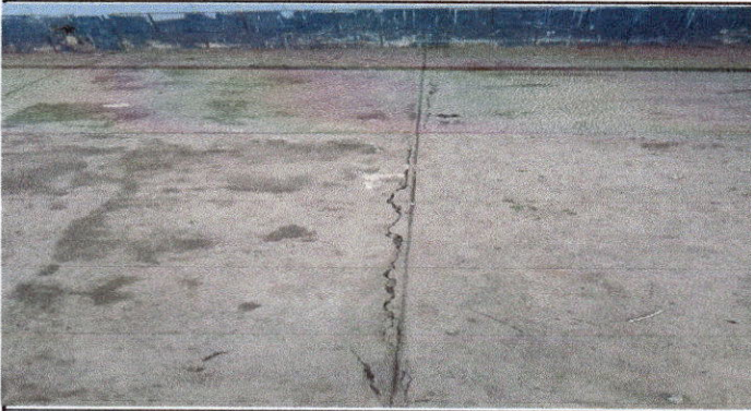
Foto 3: REMOSAMIENTO DE PISO
