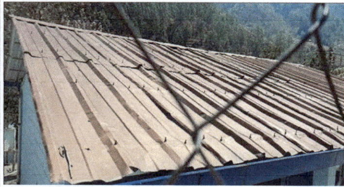
Foto 1: CAMBIO DE TECHO
