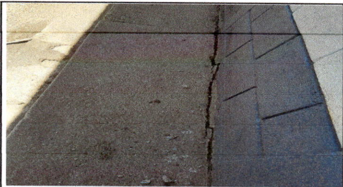
Foto 4: REMOSAMIENTO DE BANQUETA
